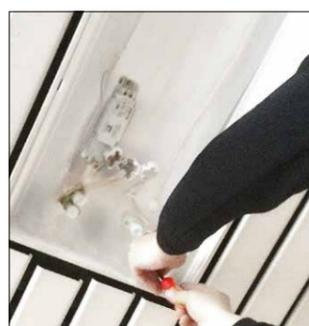
1 Demontage der alten Elektrokomponenten aus dem Leuchtgehäuse.
