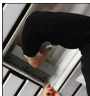
2 Montage der gelieferten Haltewinkel in das Bestandsgehäuse.
